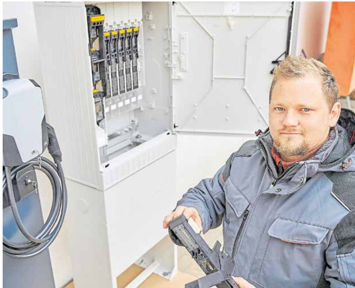
Für Industriekunden installiert die Elektro Dietrich GmbH unter anderem Ladesäulen für Elektrofahrzeuge. Hadrian Hobus betreut den Ablauf der Projekte, ist als Elektrotechnikermeister aber auch handwerklich versiert und kann jederzeit mit anpacken. Foto: HWK Halle/Yvonne Bachmann
