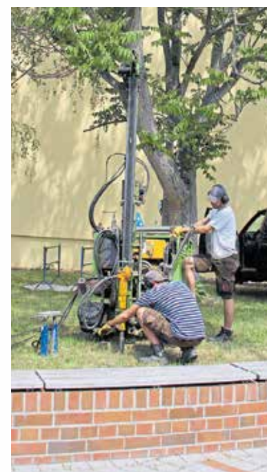
Probebohrungen am Theoriegebäude I, das abgerissen werden soll.
