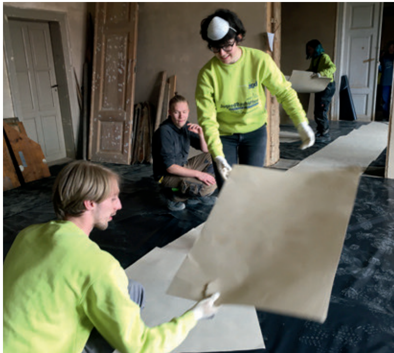
Denkmalpflege mit den eigenen Händen spüren: Restaurierungsarbeiten auf Schloss Wiehe in Thüringen
