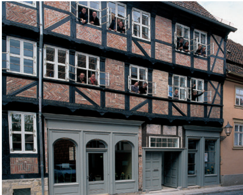
Wohn- und Seminarhaus der Jugendbauhütte Quedlinburg
